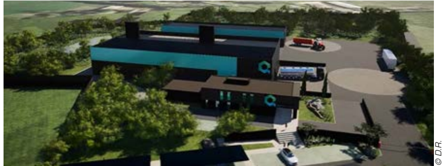
Maquette de la société Qairos Energies implantée à Trangé dans la Sarthe.
