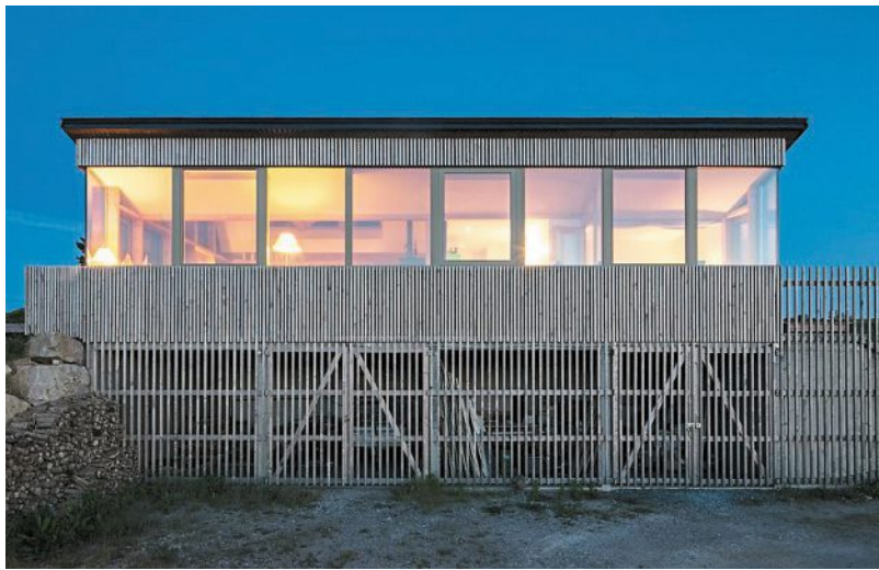
Une maison individuelle à Erquy (Côtes-d'Armor). Elle est l'une des lauréates du Prix de la construction bois 2021 en Bretagne. | PHOTO : PASCAL LEOPOLD
